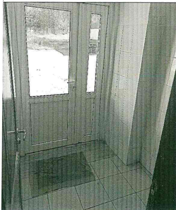
Фото 11 - Вход в корпус учреждения
